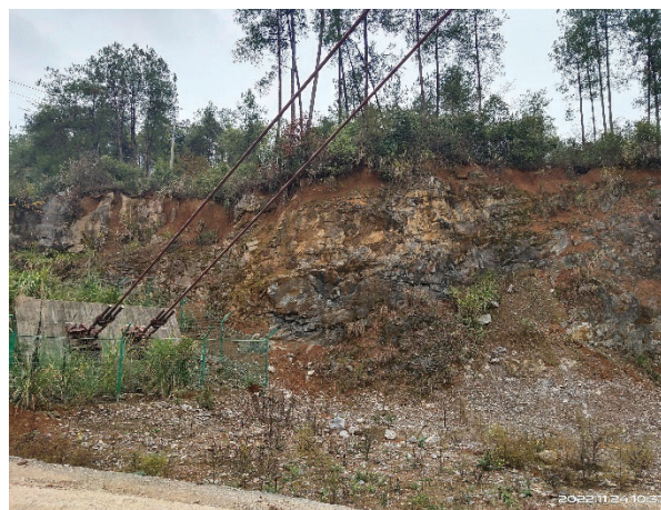
酉水悬索跨越处
