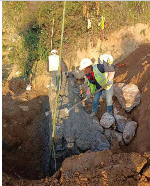
水保施工现场
