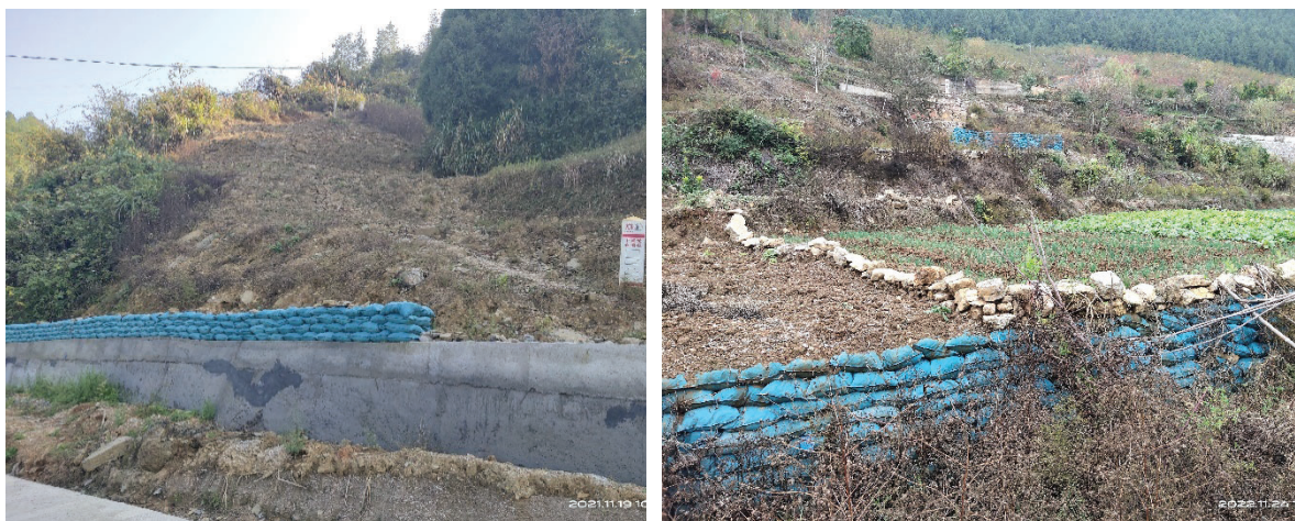
草袋素土截水墙+浆砌石护坡
