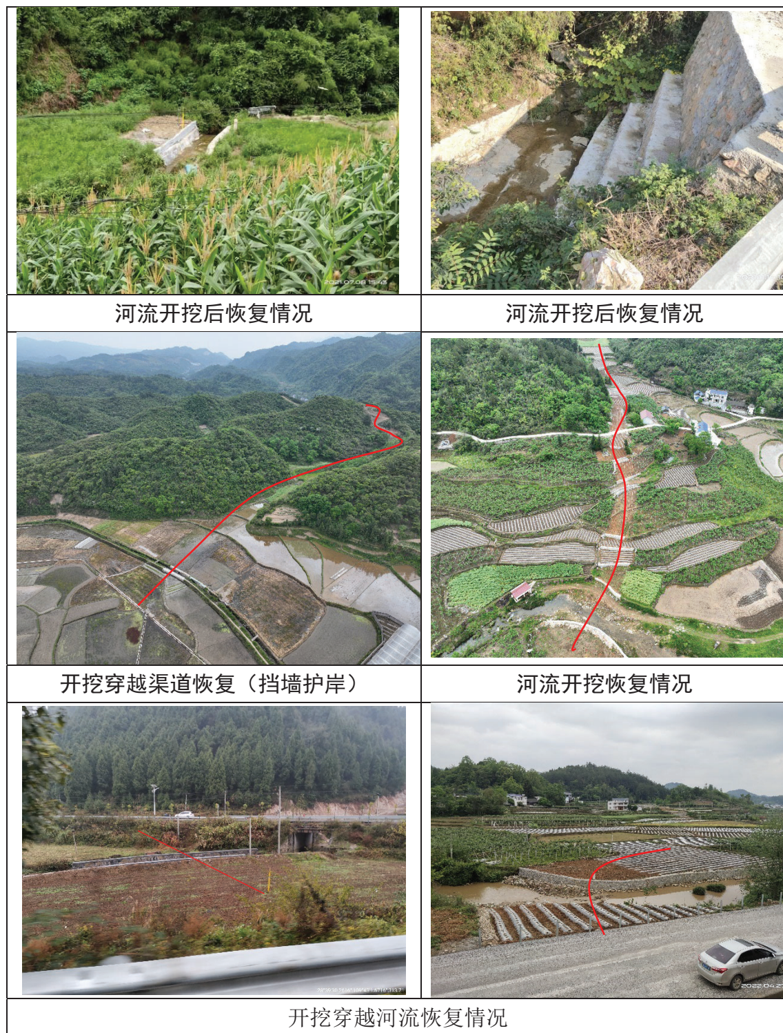
图 6.1-1 大开挖穿越河流段恢复照片
