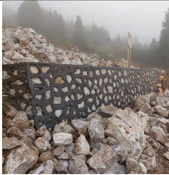
边坡砌筑现场
