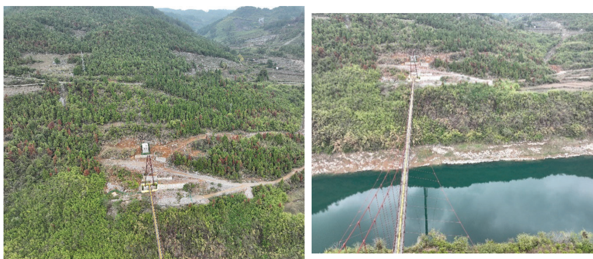
图 5.1-6 酉水跨越恢复情况
