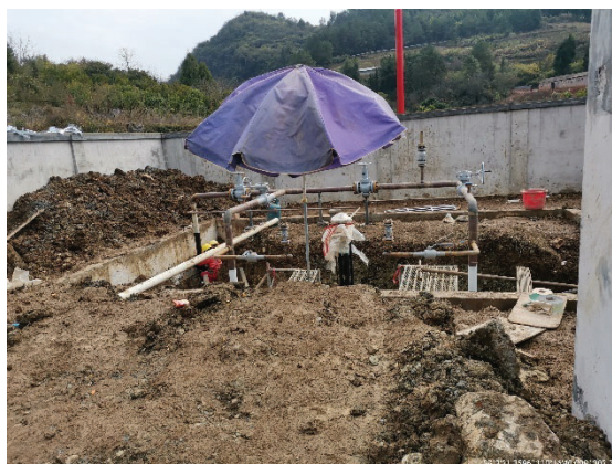
阀室建设前先建设围墙，围墙作为屏障
