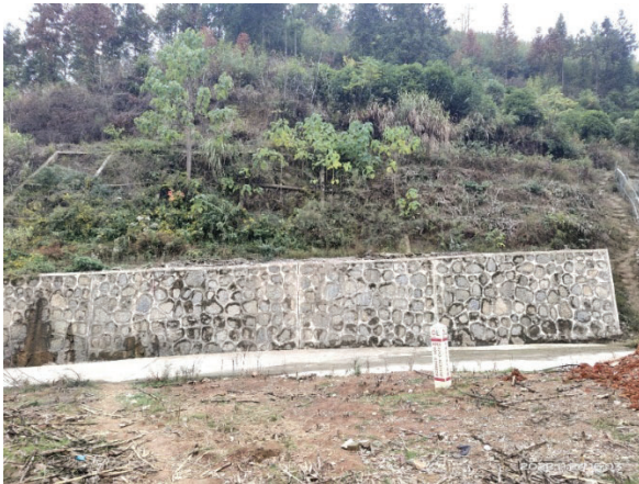
挡墙和骨架护坡
