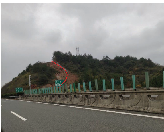
管道穿越处未有效恢复
