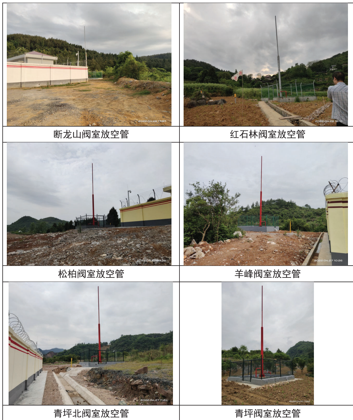
图 7.2-2 项目站场、放空管绿化情况
