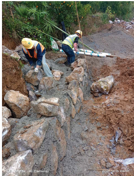
水保施工现场
