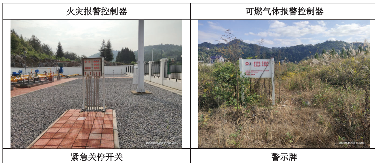
图 10.2-1 管理措施现场照片
